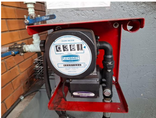
Figura 11 - Kit bomba de abastecimento e filtro na saída do reservatório IBC
